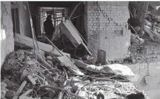
РИС. 11.5. Наслідки вибуху балону з киснево-повітряною сумішшю у Луганській міській лікарні № 7
